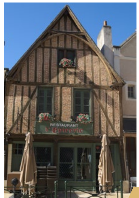
Timber-framed house (40, place Michel Debrée), Amboise, © Imola Gebauer
