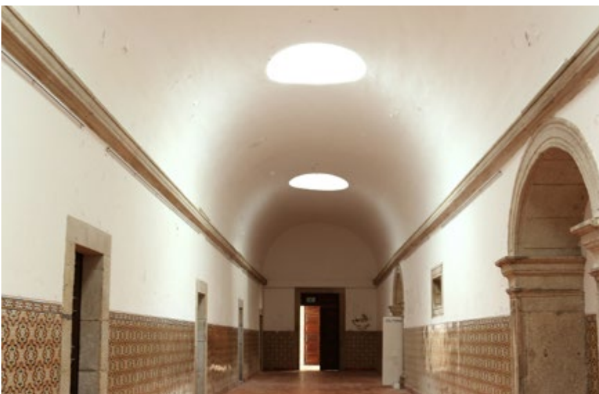
Corredor do dormitório
