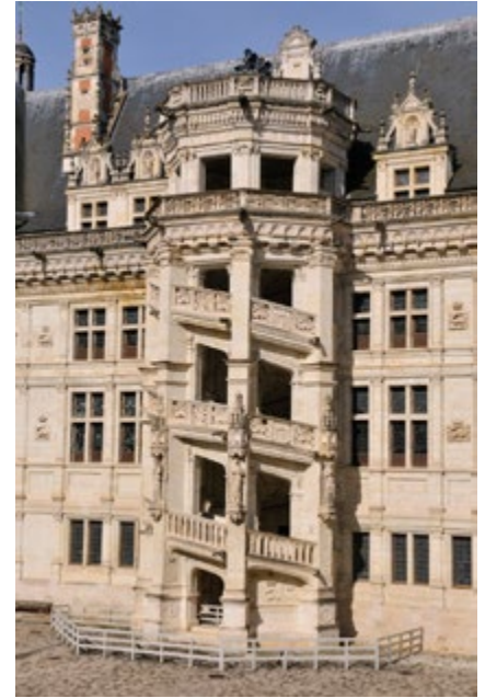
Château royal de Blois, l'aile François 1 er , l'escalier d'honneur © Laurent Masillon
